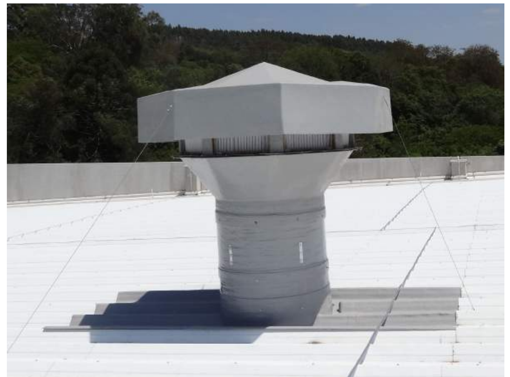
Insuflador de telhado com caixa de filtro
