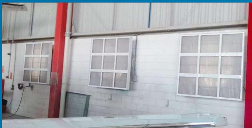
Exaustor com Filtro Instalado
