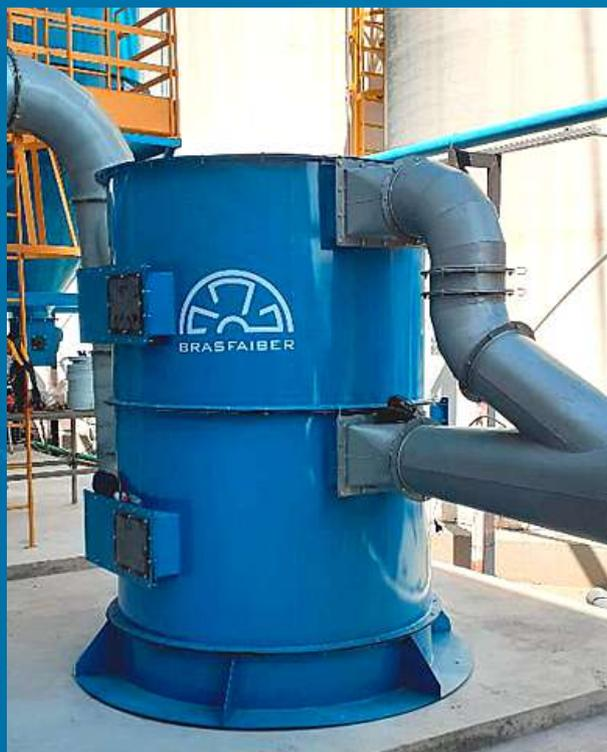
O filtro de carvão ativado possui características únicas que auxiliam na eliminação de poluentes com alta concentração de odores. Com propriedades especiais, ele é utilizado como sistema de filtragem industrial, removendo compostos orgânicos voláteis, entre outros poluentes gasosos provenientes das operações em indústrias alimentícias, químicas, farmacêuticas, entre outras.
