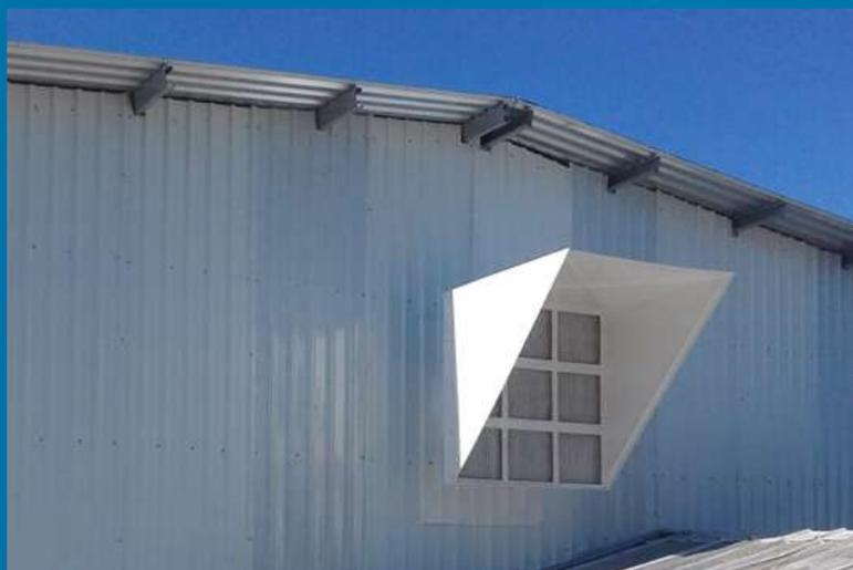
Ventilador com Filtro Instalado
