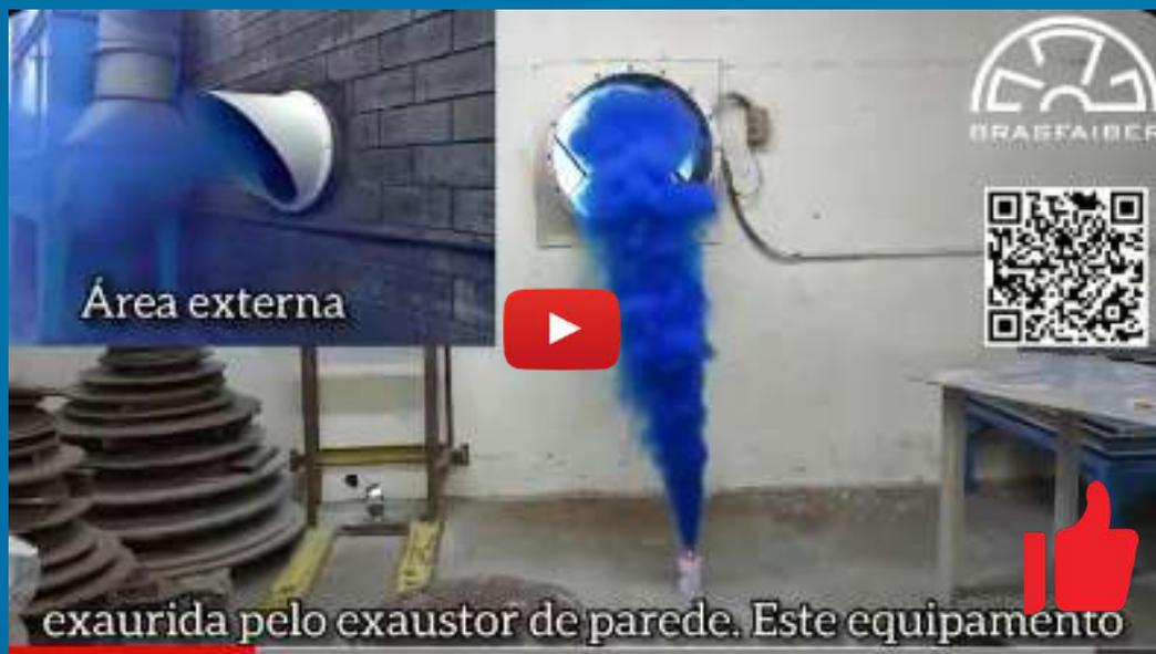
Exaustor de Parede em Funcionamento
